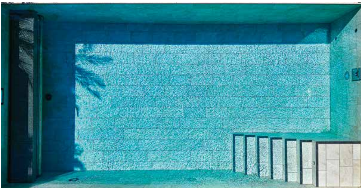
Die Beckenauskleidung gibt dem Wasser ein glitzerndes, mediterranes Flair. Die Einstiegstreppe ist betoniert und ebenfalls mit Feinsteinzeug belegt.
