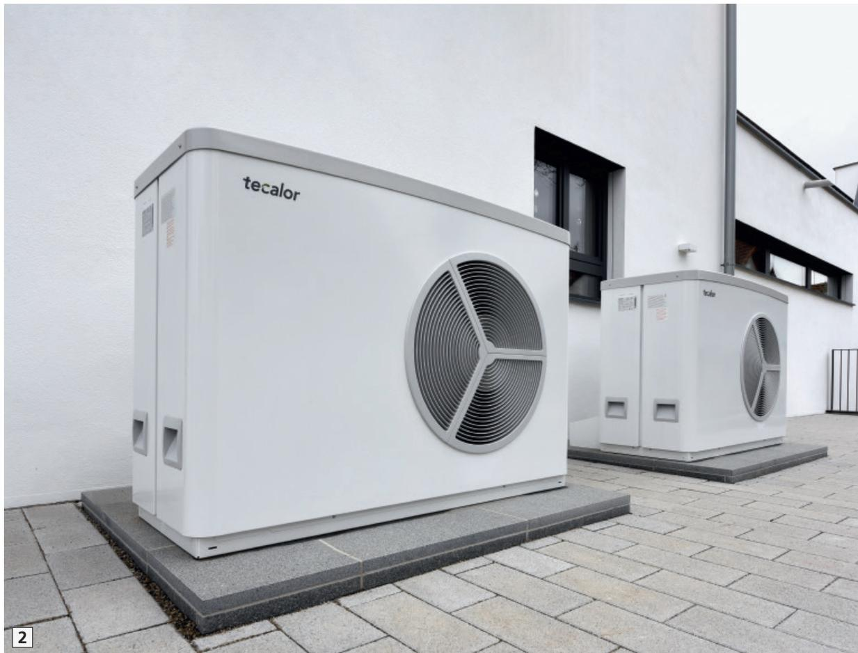
**2** Die beiden Luft/Wasser-Wärmepumpen „TTL 25 AC“ übernehmen sowohl die Beheizung der Räume, des Schwimmbads und des Wassers im Schwimmbecken als auch die Raumkühlung.
