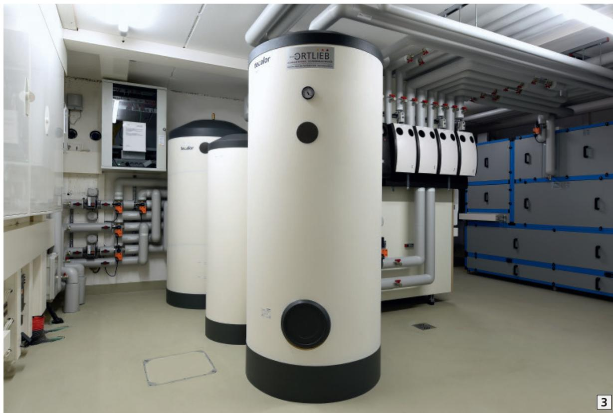
3 Um die Versorgung mit Wärme, Kälte und Brauchwarmwasser jederzeit sicherzustellen, war der Einbau von drei Speichern notwendig.
