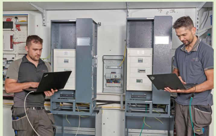
**14** Hier programmieren die Monteure, in welcher Reihenfolge die Verbraucher mit Solarstrom versorgt werden.
