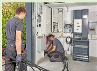
**4** Für die Einrichtung der Speicher ist jede Menge Kabelarbeit erforderlich.
