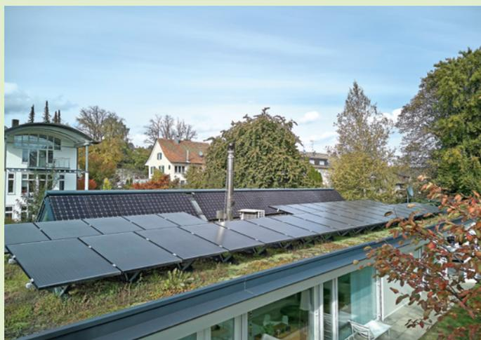
**2** Bei der Installation der Anlage wurde darauf geachtet, dass das Gründach weiterhin seine Funktionen erfüllen kann.
