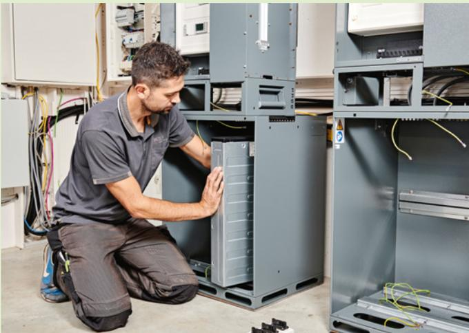
**11** Hier schiebt der Installateur eines der Speicheraggregate an seinen Bestimmungsort.
