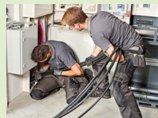
**5** Die notwendigen Leerrohre waren bereits beim Bau der PV-Anlage eingerichtet worden.
